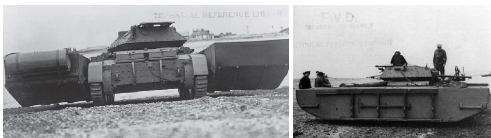
107. kép: Egy Series 3 pontonokkal szerelt Covenanter hátul és oldalnézete. 664
