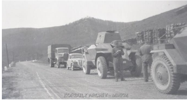
48. kép: A 39 M. Csaba első két, sorozatgyártott, lágyacél felépítményű, fegyverzet nélküli, csak kiképzésre használt példánya. A háttérben egy 39 M. Ford-Marmon-Herrington teherautó. 394
