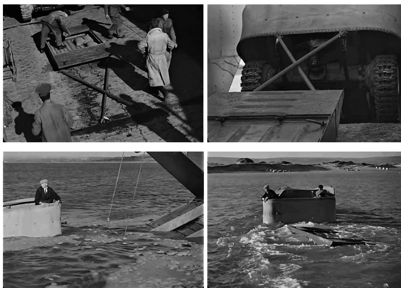
185. kép: Egy kísérlet, amelyben egy Porpoise-t vontató Valentine DD-vel vizsgálták az elképzelt működőképességét. 1084
