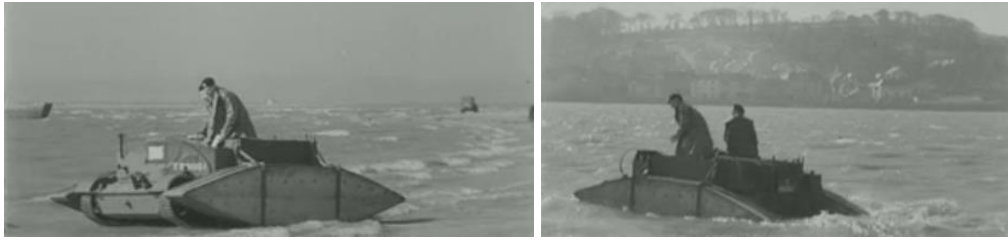
109. kép: A Straussler-féle felcsatolható pontonok segítségével úszó Universal Carriert tesztelik 1943-ban. 669
