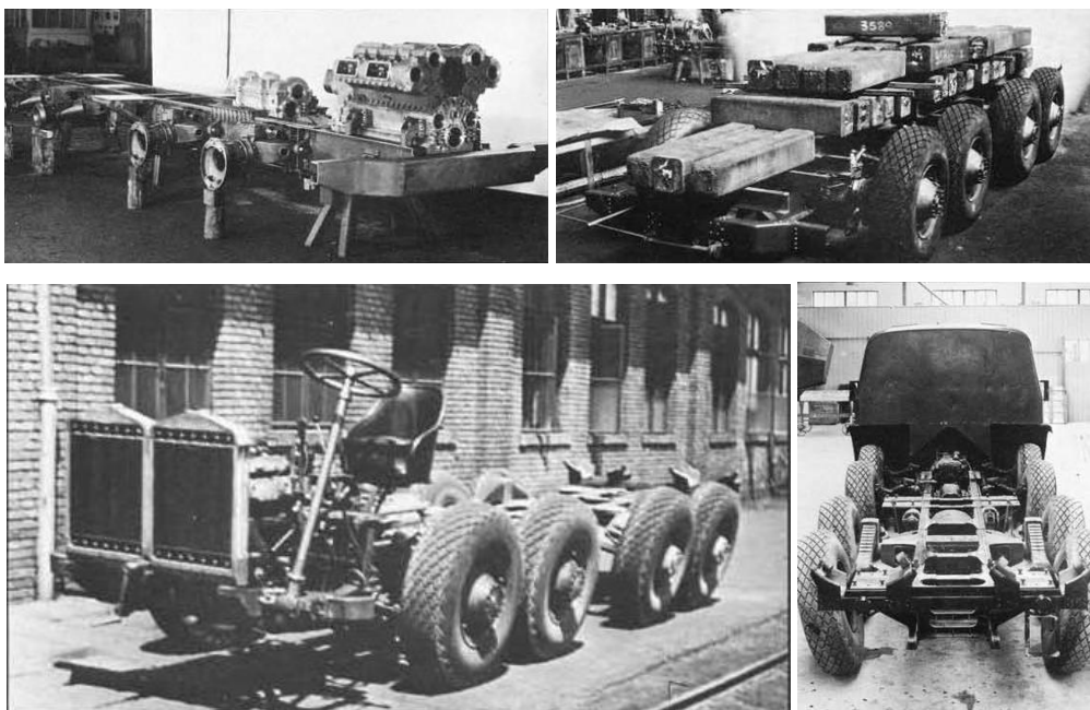
80. kép: Az AP-1 alváza építés és tesztelés közben Csepelen. 537
